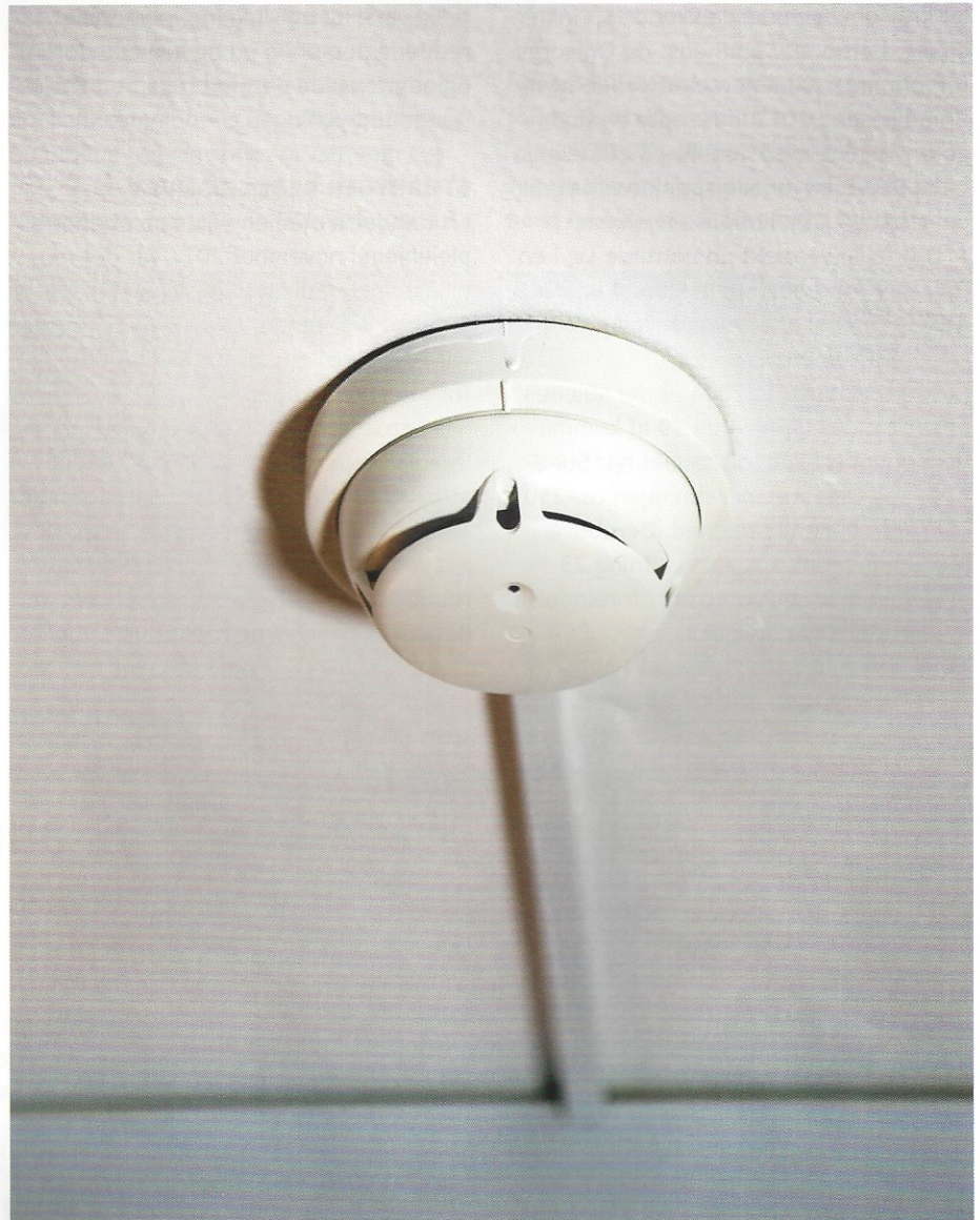
Tågedysen aktiveres via en almindelig sensor i loftet. Foto: Københavns Brandvæsen.
